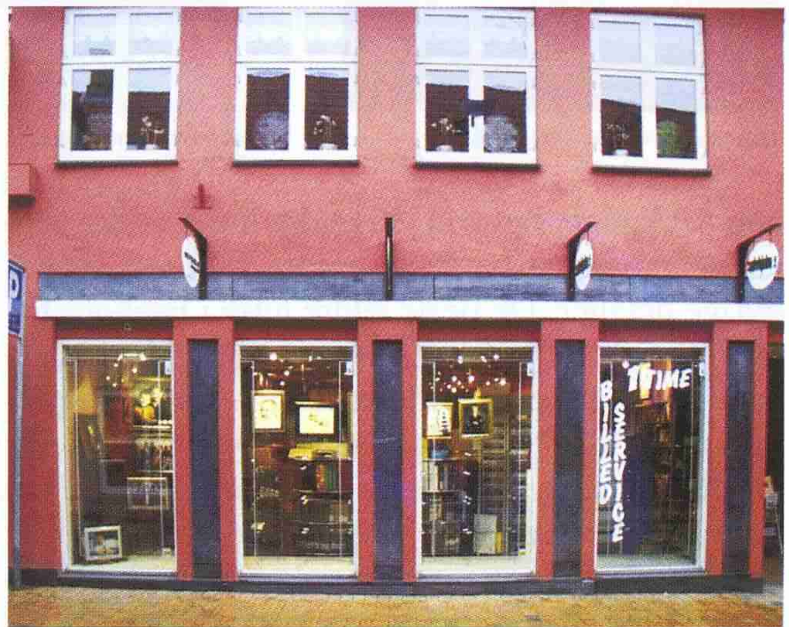
Butiksfacade, hvor husets fagopdeling og konstruktive helhed er fastholdt. Detaljeringen og sammenhængen med huset i øvrigt kunne dog have været bedre: Det hvide bånd er uheldigt, da det skærer facaden visuelt over.
