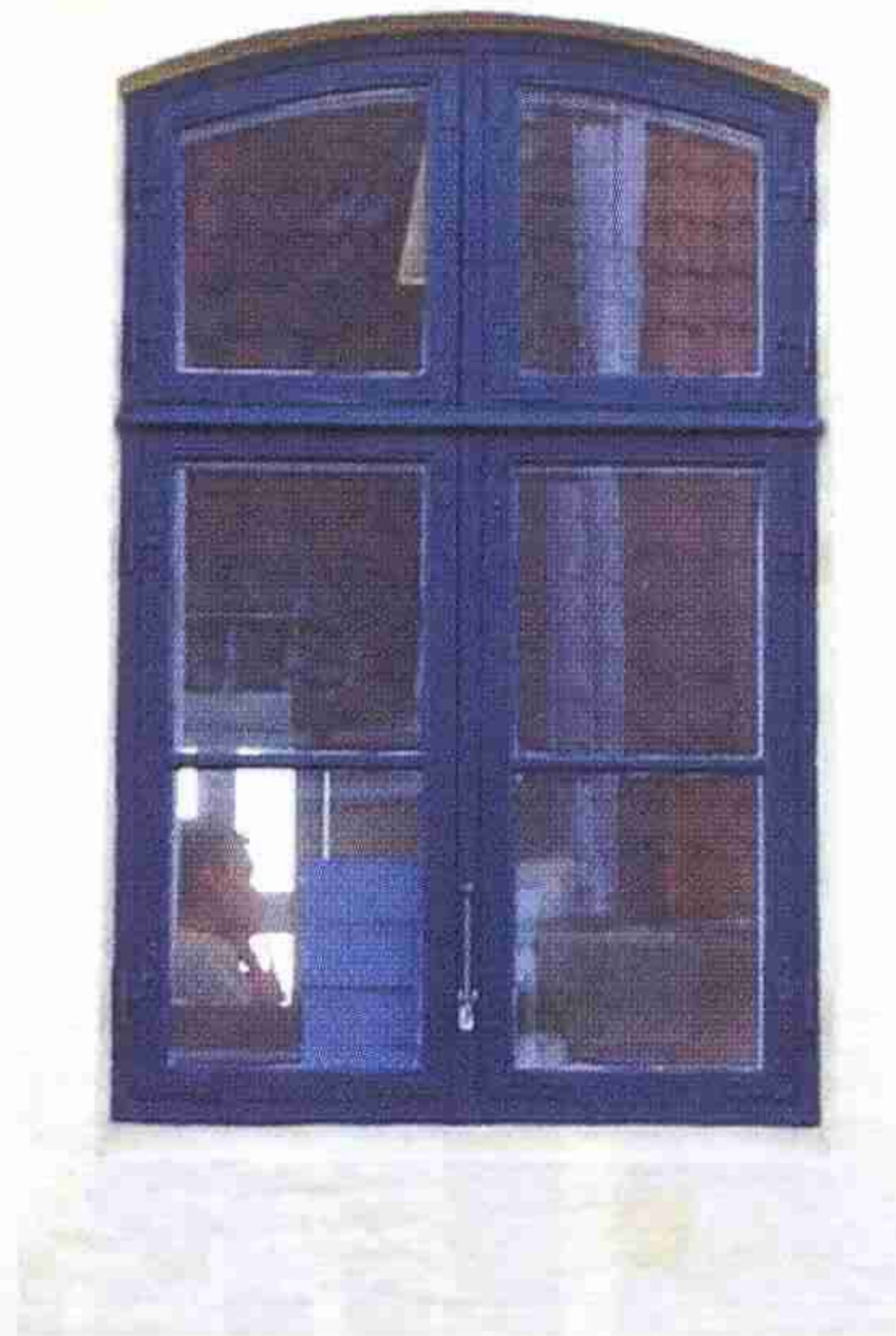
Korspostvindue med sprosser. Bryggergården
