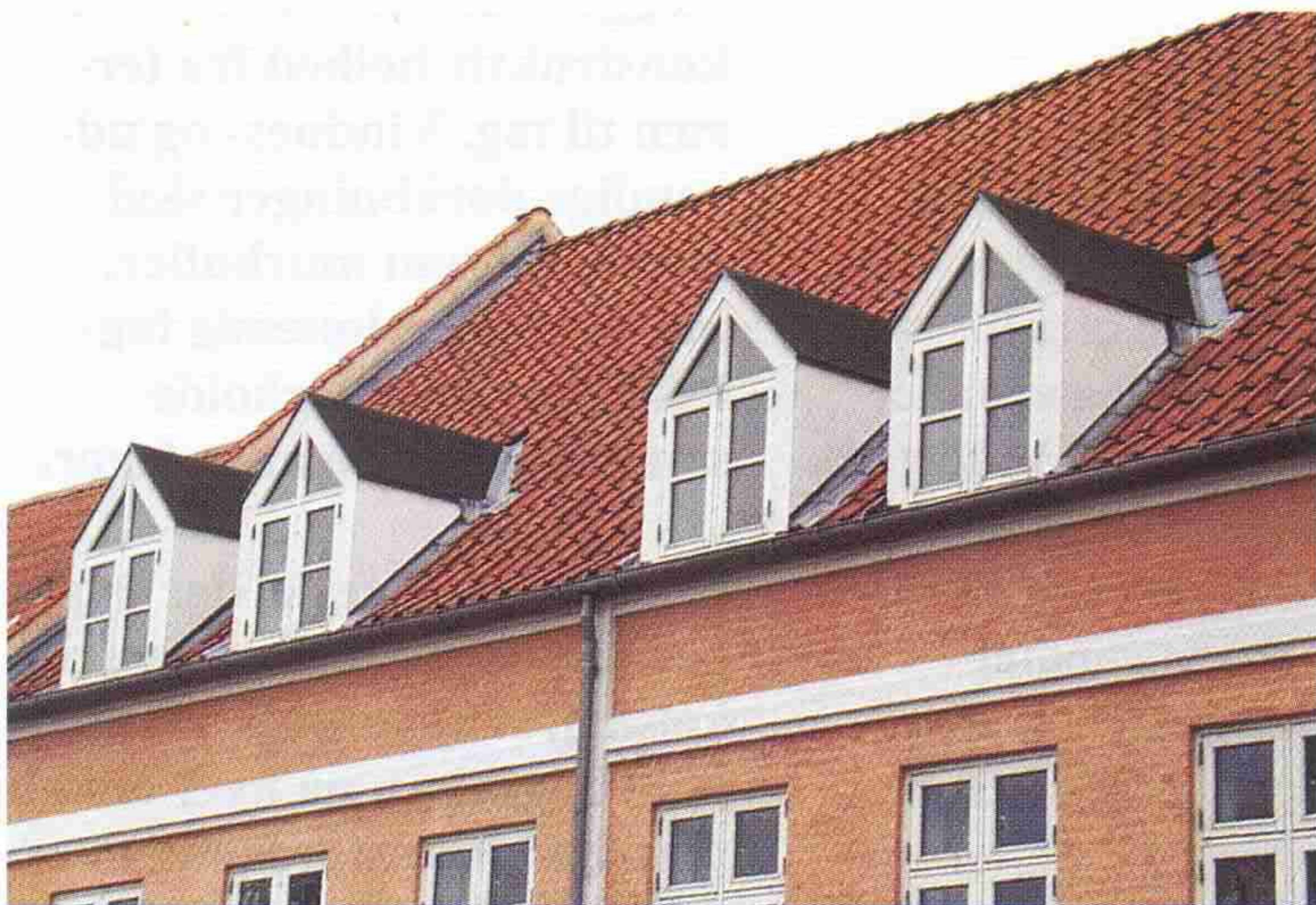
Kviste kan være i 1990'ernes formsprog, men tilpasset omgivelserne. I dette tilfælde er de dog placeret for lavt i tagfladen.
