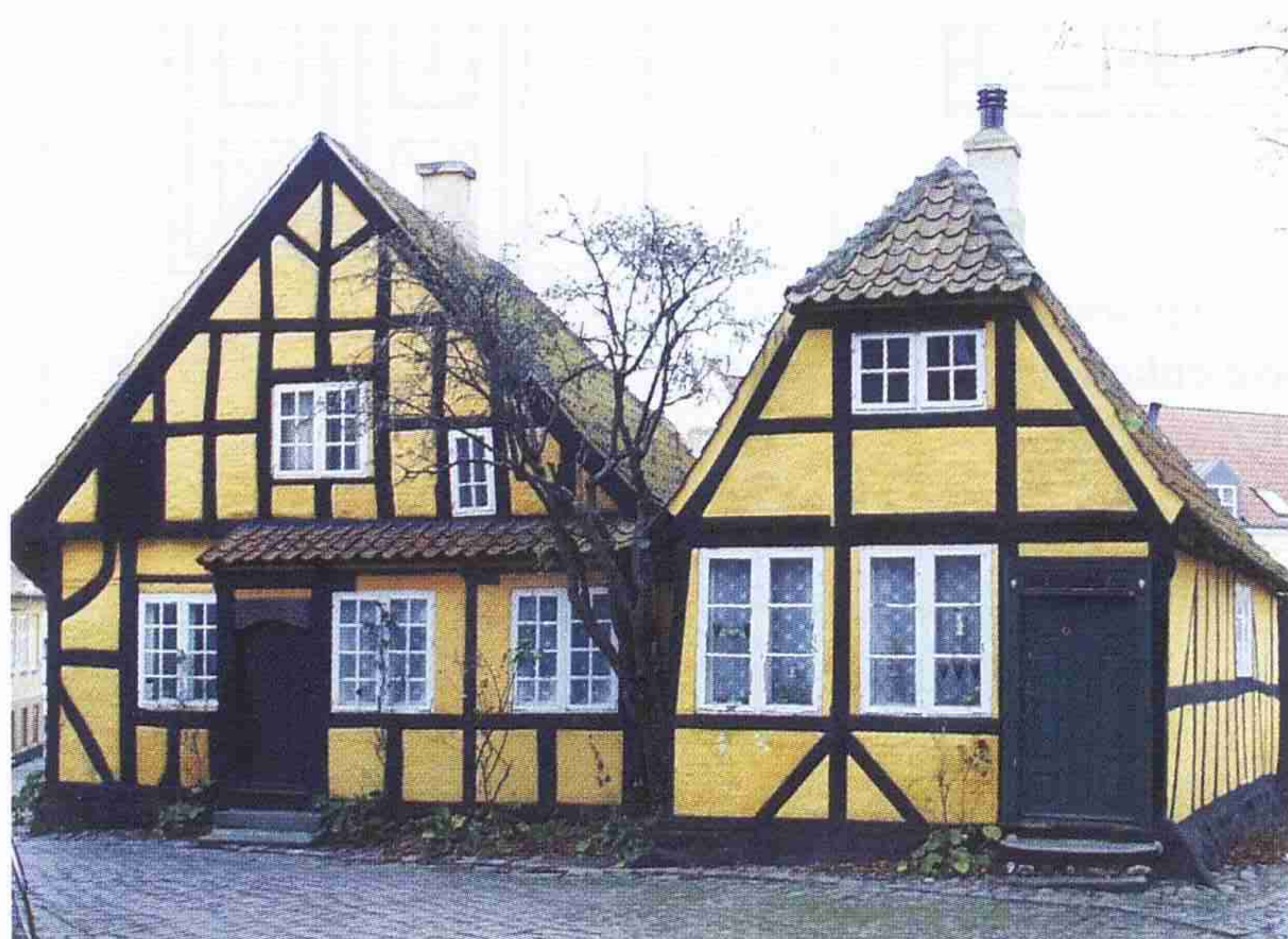
Her er en del af husets oprindelige 1700-tals vinduer bevaret. Holkegade.
