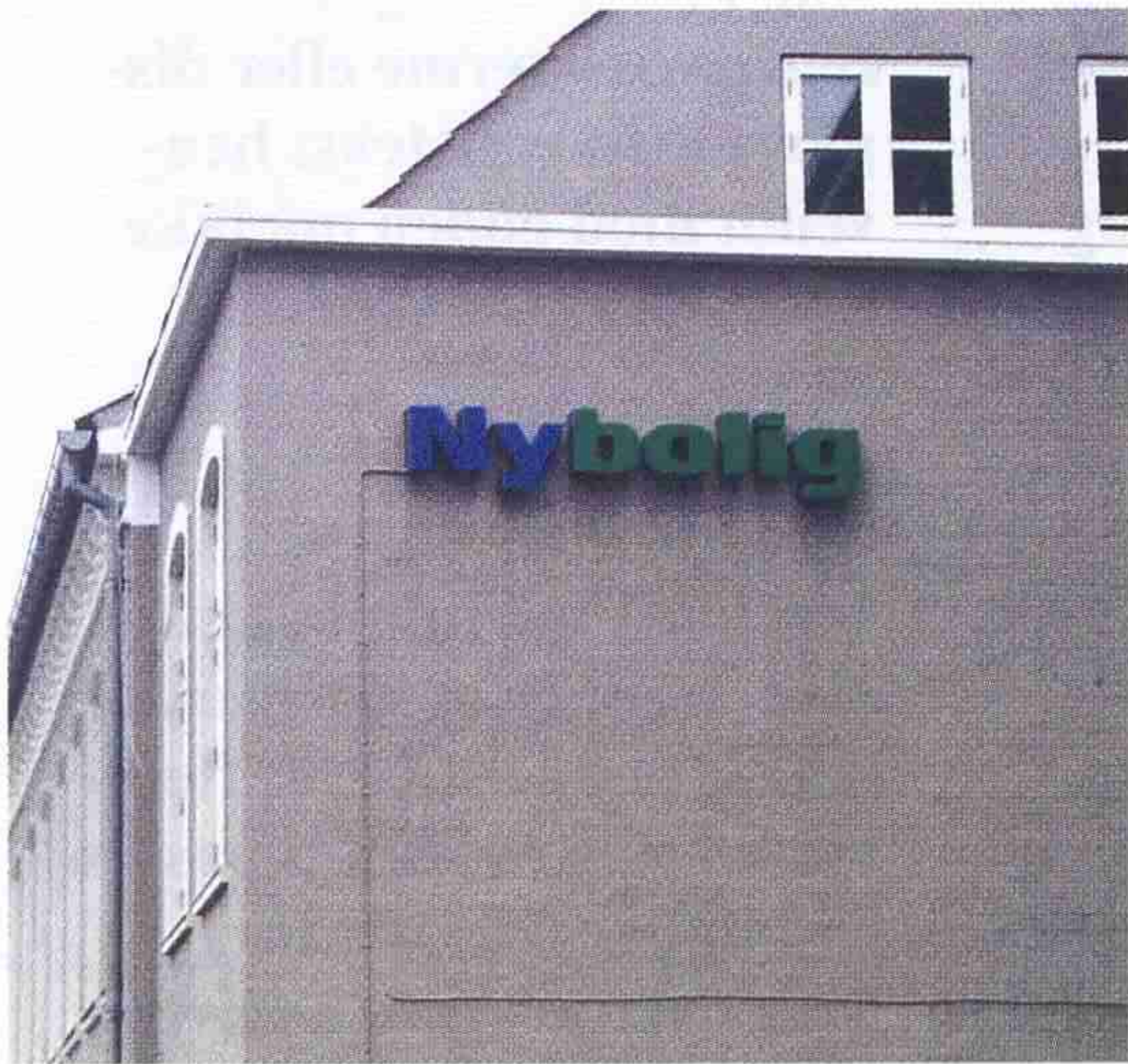
Velproportioneret facadeskilt, der dog skæmmes af den udvendige ledningsføring.
