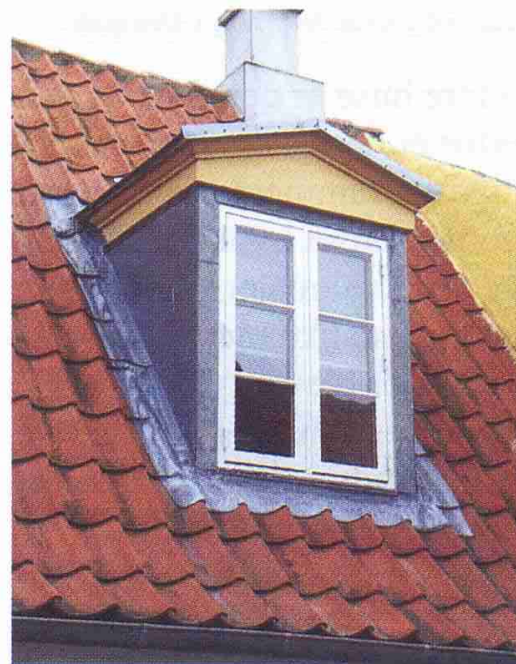
Kvist med gode detaljer, der dog skæmmes af en voldsom inddækning.
